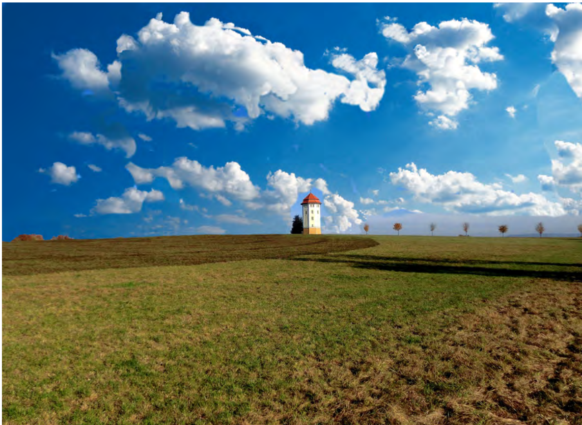
Hermann Schürle: Alter Wasserturm in Hohenstadt Old watertower, Hohenstadt Vieux château d'eau à Hohenstadt Antica torre cisterna in località Hohenstadt
