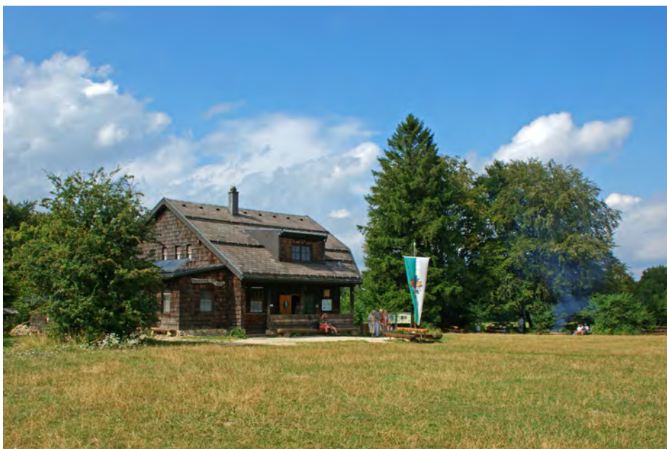
Andreas Petschke: Franz-Keller-Haus auf dem Kalten Feld bei Degenfeld The Franz-Keller-House on the Kaltes Feld at Degenfeld „Franz-Keller-Haus“ sur le „Kaltes Feld“ près de Degenfeld La „Casa del Viandante“ Franz Keller sul Kalten Feld presso Degenfeld
